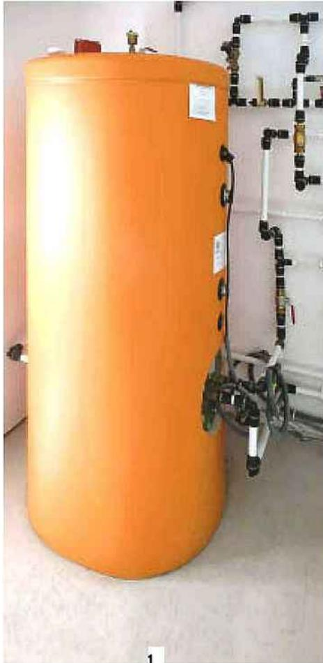
1. L'eau chaude sanitaire (sur la photo, le réservoir de stockage + Eco Pac de marque Charot) ainsi que le chauffage (par gainables) sont produits au moyen d'une pompe à chaleur Altherma de Daikin.
