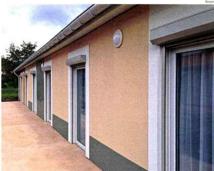
Serainor conçoit des résidences seniors à coûts maîtrisés et équipées de domotique.
